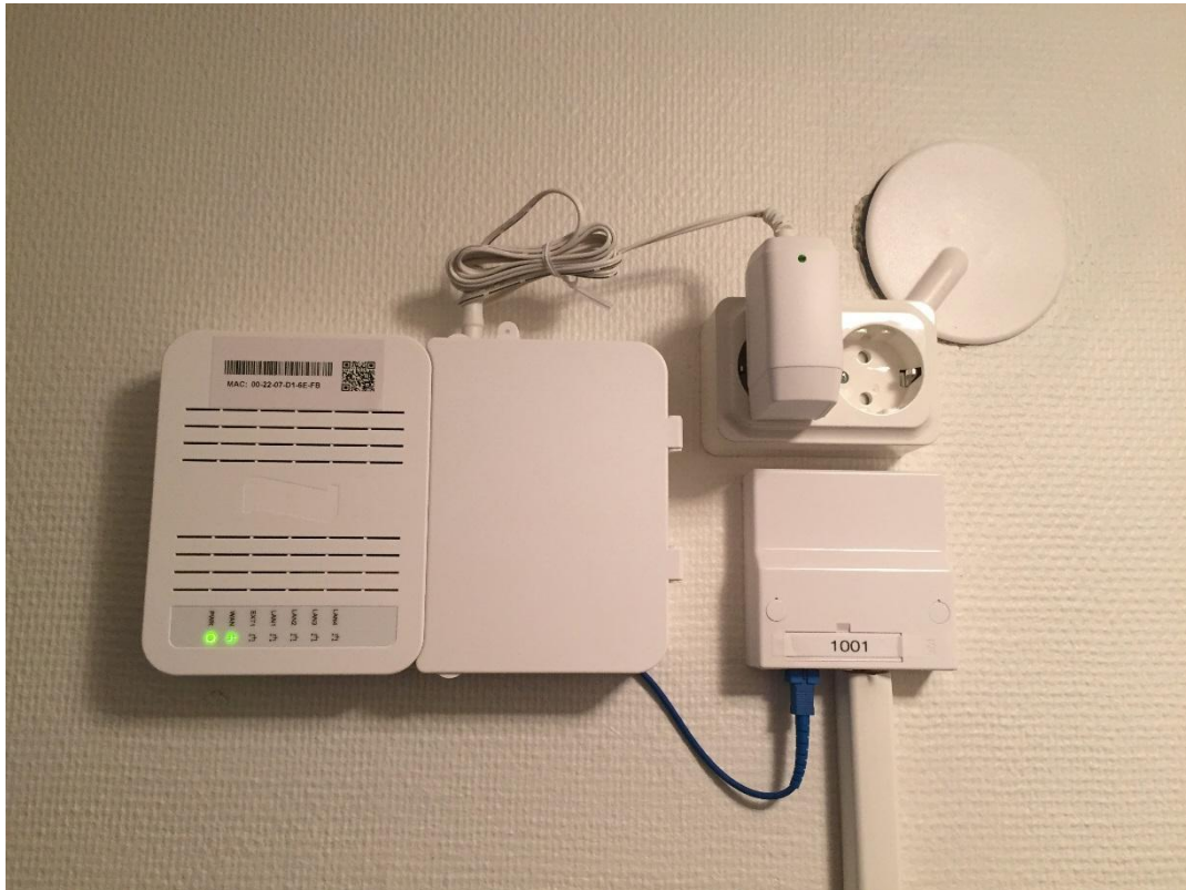
Bild 1: Standardinstallation av fiberomvandlare (21*14*4 cm).
